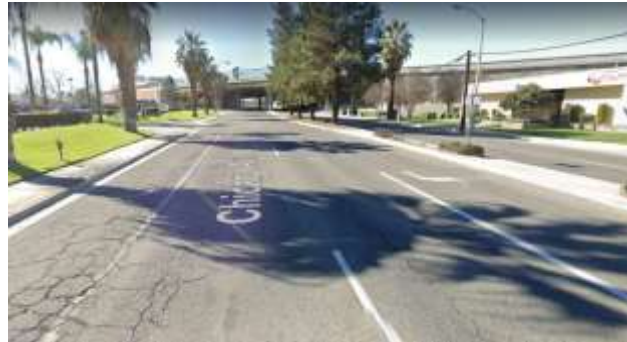
Chicago Av - W Linden St to Spruce St (Buffered Bike Lane)
