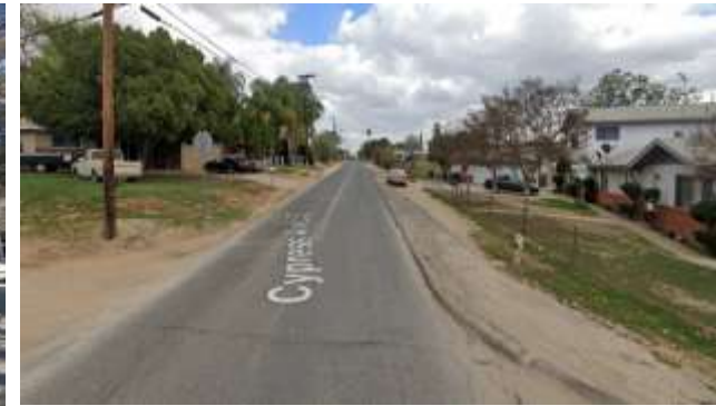
Cypress Ave - Golden Ave to Van Buren Blvd (Bike Lane)
